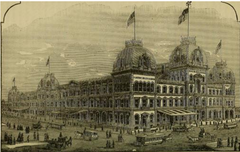
Figura 1.20.1. Transporte de carga y pasajeros, Estación Pennsylvania, NY
