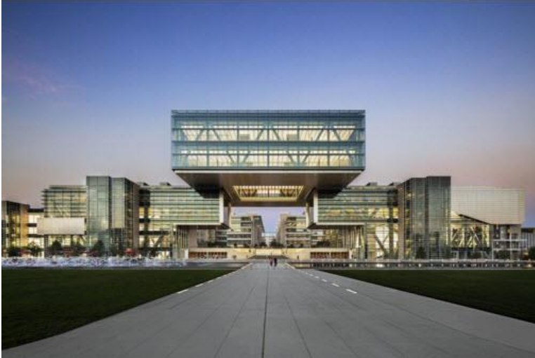
Figura 2.1.8. Edificio Exxon-Mobil en el centro de Houston, Texas, EE.UU.
