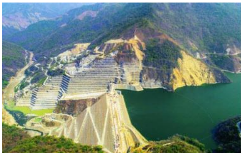
Figura 2.25.9. Represa de Hidroituango
