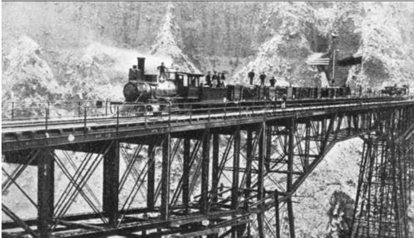
Figura 2.2.6. Verrugas puente originales en el ferrocarril construido por Meiggs
