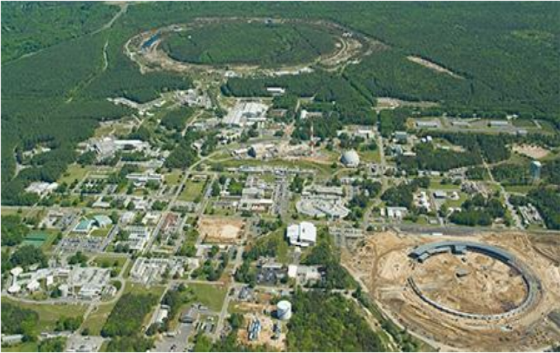
Figura 3.3.7. Túneles subterráneos del Colisionador Electron Ion (EIC), en Brookhaven, South Dakota, USA.
