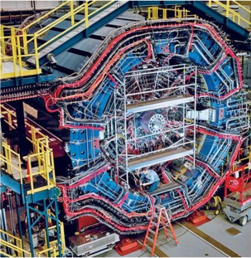
Figura 3.3.9. Foto tomada durante la construcción del EIC en Brookhaven.
