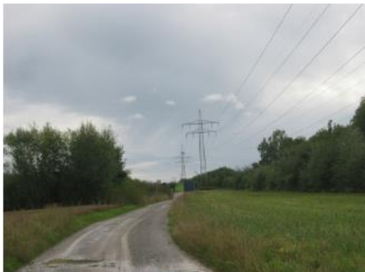
Figura 3.14.15. Esta línea eléctrica de tracción de alto voltaje que va a la Subestación Ferroviaria de Eutingen en Alemania irradia ondas electromagnéticas con longitudes de onda muy largas. (crédito: Zonk43, Wikimedia Commons)
